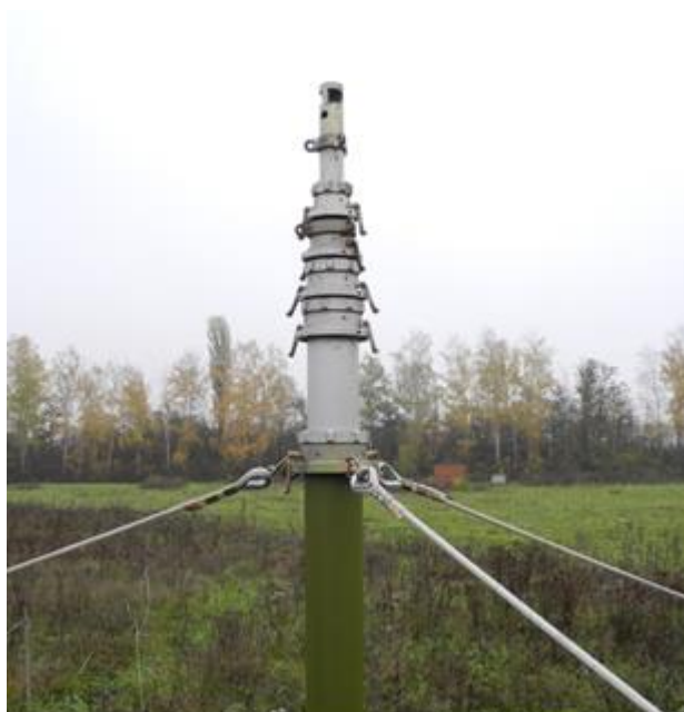
Рисунок 7.16. – Закрепление мачты оттяжками 1-го яруса
