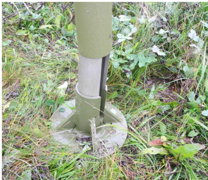
Рисунок 7.15. – Установка мачты на основание
